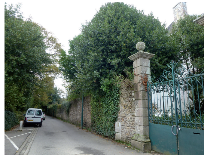
Mur maçonné à l'alignement dans la rue St-Jacques
