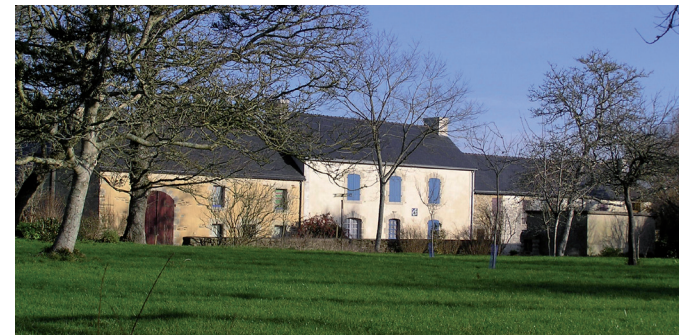
Alignement de toitures en ardoise à St-Maudez (logis et communs 1876)
