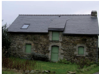
Exemple de lucarne gerbière (ci-contre) et de lucarne-pignon (ci-dessous) à Kernou
