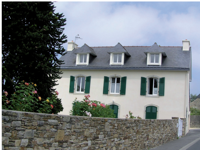
exemple de façade enduite à la chaux
