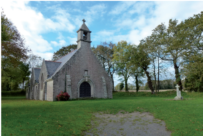
Eglise et chapelles : une attention particulière à porter à l'aménagement des abords
