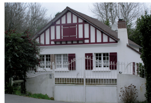
Exemple de façade à colombages apparents
