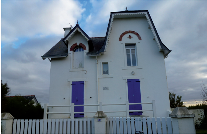
Les toitures à pans multiples de l'architecture balnéaire se prêtent rarement à l'implantation de panneaux
