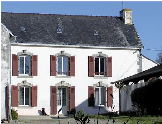
Logis rural, repéré comme bâtiment d'accompagnement
