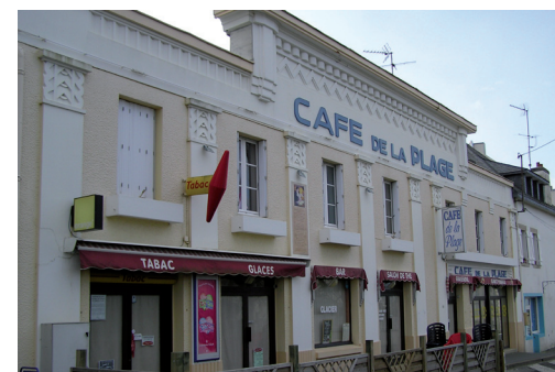
Exemple de façade Art Déco
