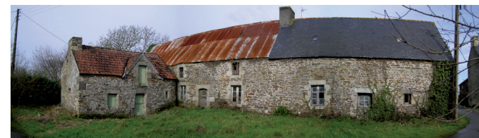
Mixité de matériaux de couvertures à Kernou : toitures en ardoise et en tuile autorisées, et en tôle ondulée à proscrire
