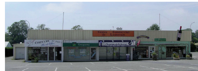
exemple de bâtiment hors gabarit rue de Lannevain
