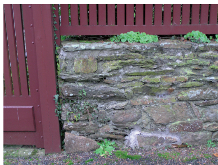
Exemple de muret en pierres naturelles à joints beurrés
