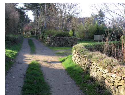
Exemple de murets en pierres sèches
