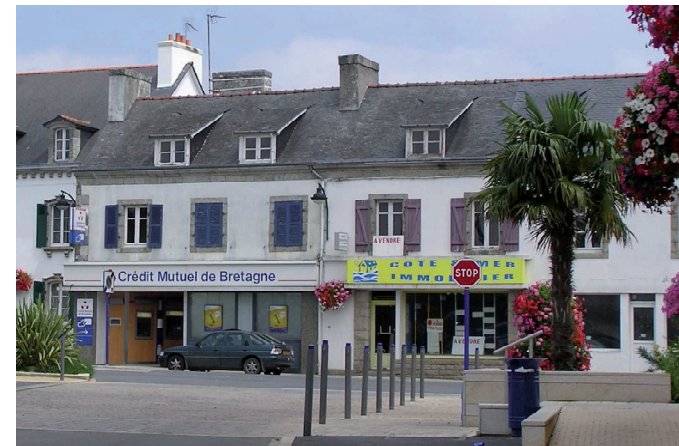
Deux maisons de bourg, repérées comme bâtiments d'accompagnement
