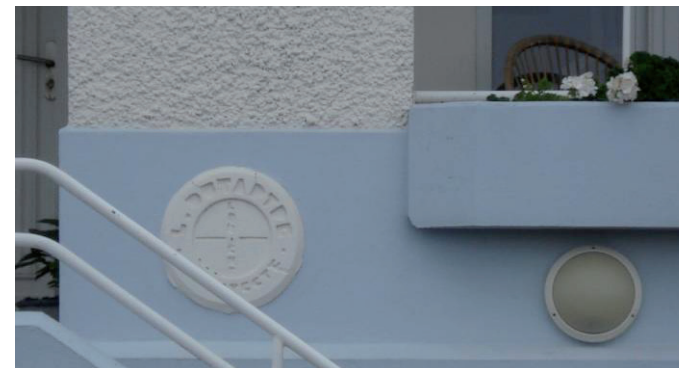
Exemple de monogramme en ciment moulé, élément caractéristique à conserver
