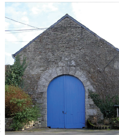
Grange repérée comme bâtiment d'intérêt
