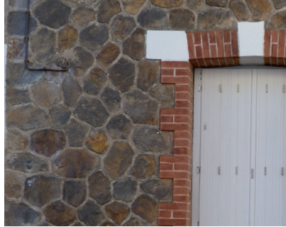
exemple de mise en œuvre «opus incertum»
