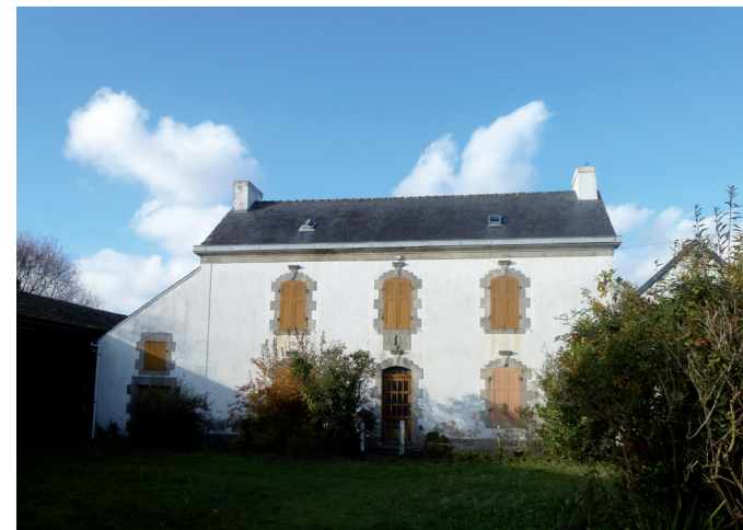
Logis à Kervéo, repéré comme bâtiment d'intérêt
