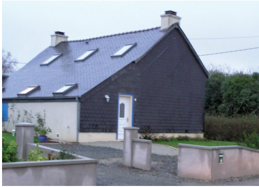
Exemple de bardage ardoise en pignons non autorisé
