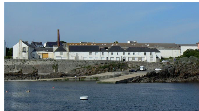
La conserverie avant sa démolition en 2008 (V.Johan, GEOMER/SRI)
