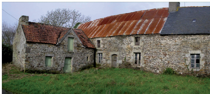
Exemple de lucarne gerbière (ci-contre) et de lucarne-pignon (ci-dessous) à Kernou
