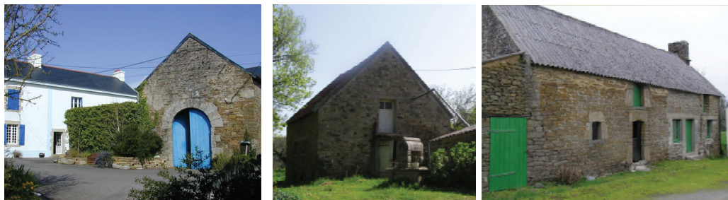
Logis, grange, remise, puits, étable, etc. : un bâti agricole varié caractérisant les hameaux ruraux
