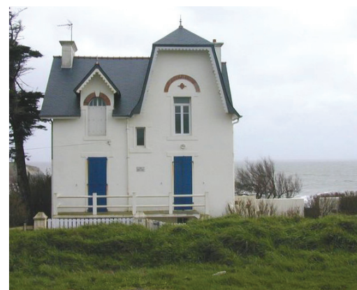
Maison «Stella Marys», plage du Kerou : L'enjeu de conservation des caractères architecturaux du patrimoine balnéaire amène à limiter le champ des réponses possible aux enjeux énergétiques
