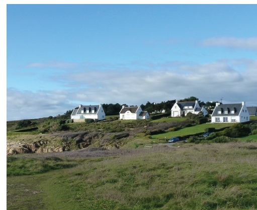
Maisons récentes en front de mer : l'amélioration énergétique pouvant modifier radicalement l'aspect extérieur, une attention particulière est à porter sur les projets avec un fort impact paysager ou en covisibilité avec un bâtiment remarquable
