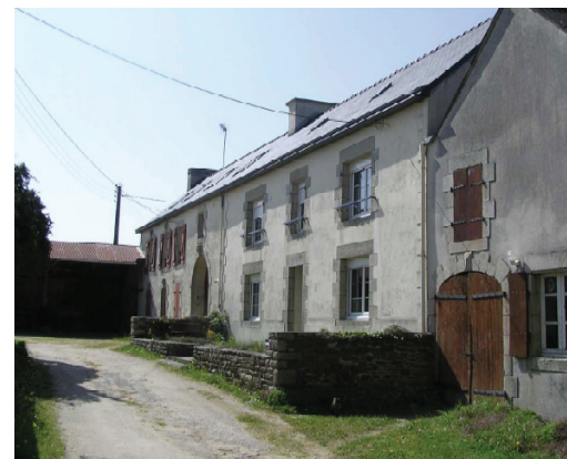
Kerroué, étable, logis et remise : la prise en compte des enjeux énergétiques lors de rénovation a peu d'impact extérieur, à l'exception du changement de menuiseries, souvent remplacées en PVC avec mise en place de volets roulants
