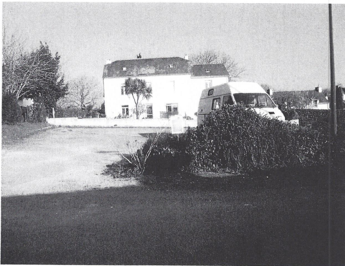
Photo n°9 : Route de Posmoric
