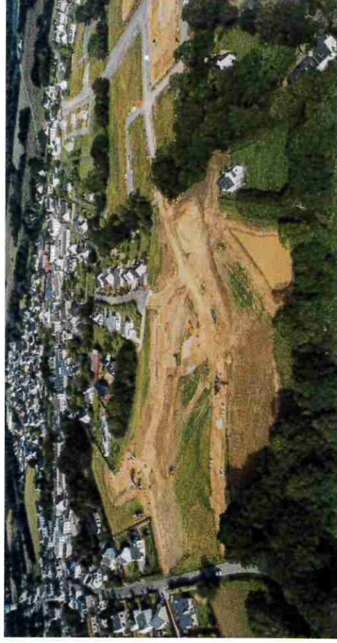
Vue aérienne Travaux de viabilisation du Secteur Nord de la ZAC - Juin 2018
