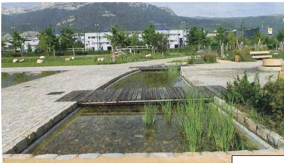
Bassin tampon paysager
