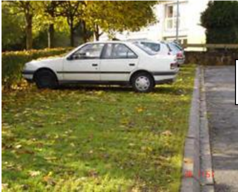
Parking engazonné perméable
