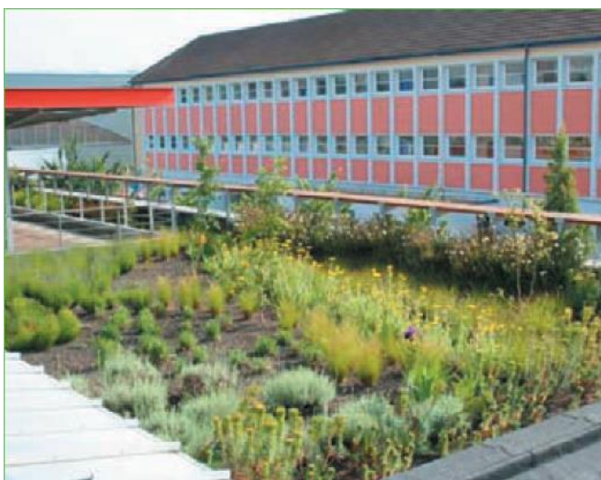
Toiture stockante végétalisée
