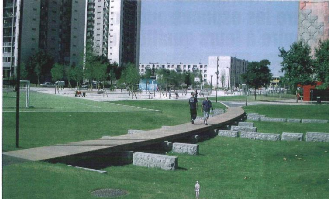
Bassin tampon paysager
