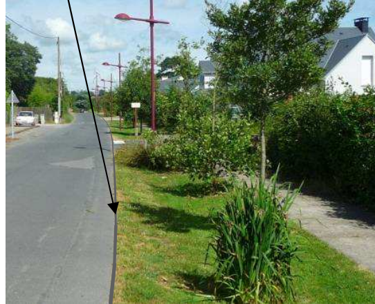
Exemples d'espaces verts en creux recueillant les EP de la chaussée et du chemin
