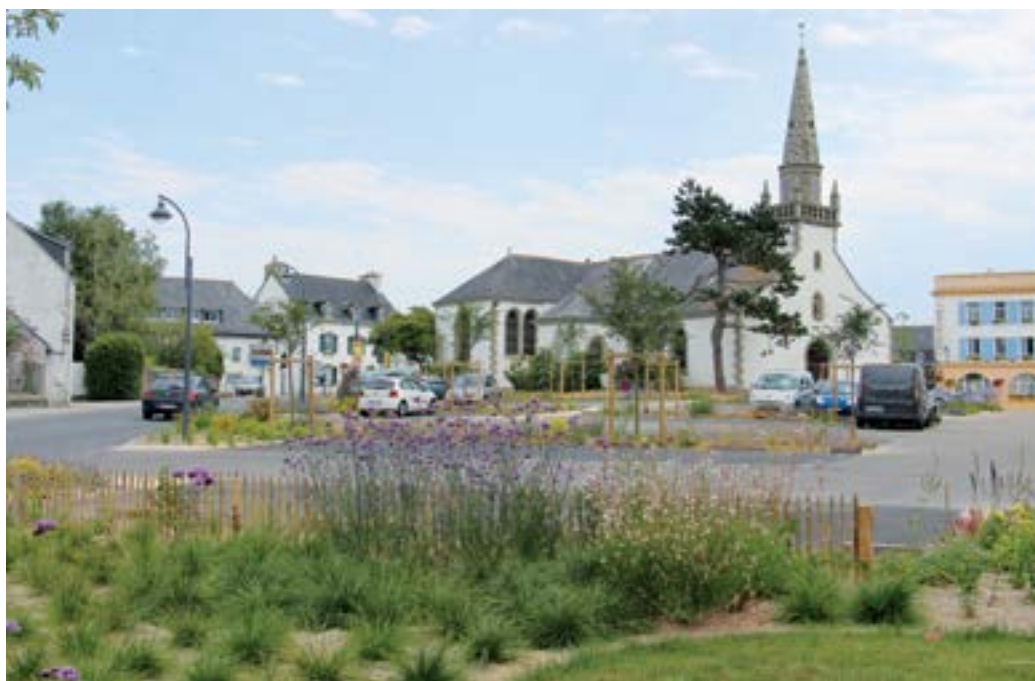
Place de l'église, avant et après travaux
