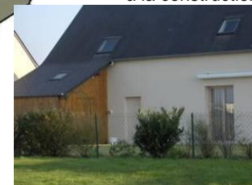
Abri de jardin accolé à la construction
