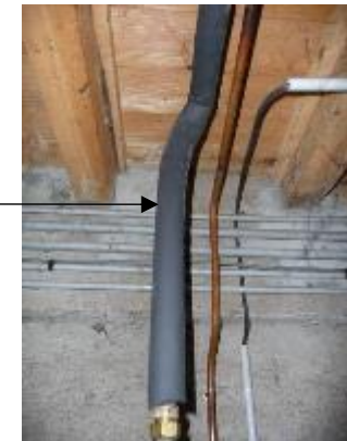
Tuyaux calorifugé
