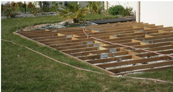
Terrasse en cours de réalisation d'un logement individuel.
