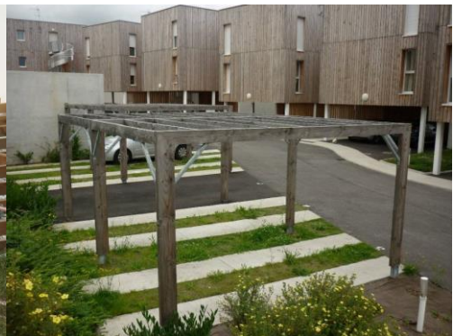
Stationnement : espace perméable entre bande de roulement
