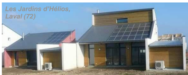
Panneaux photovoltaïques (électricité) associés à une pompe à chaleur (chauffage+ECS)
