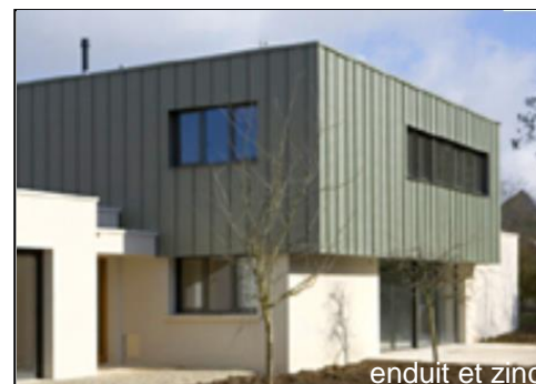
enduit et zinc
