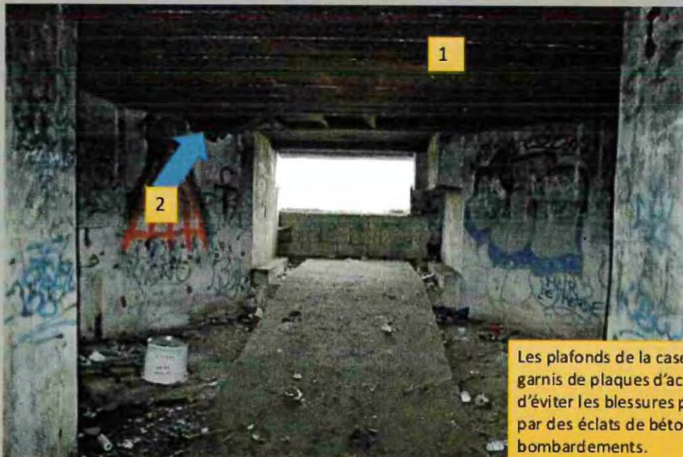
Les plafonds de la casemate sont garnis de plaques d'acier afin d'éviter les blessures provoquées par des éclats de béton lors des bombardements.
